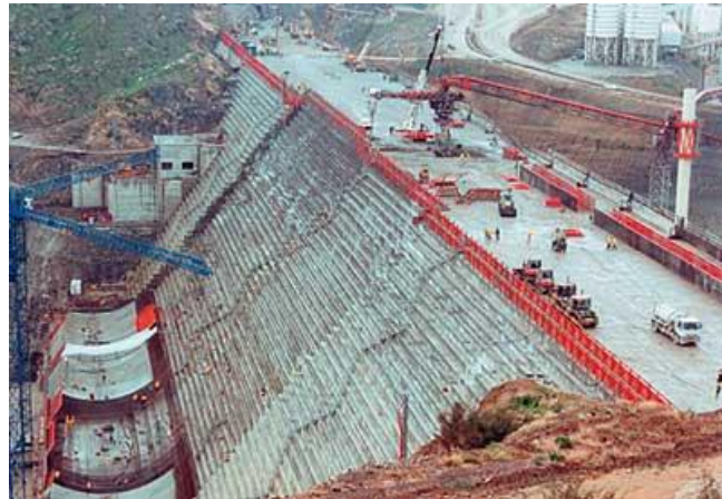
Fig. 15a. Barrage poids en construction (Beni haroun, Algérie)
