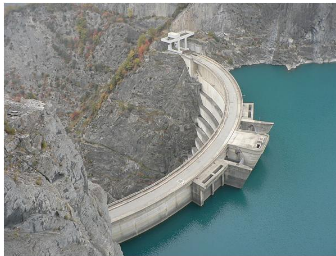
Fig. 16a. Barrage voûte
