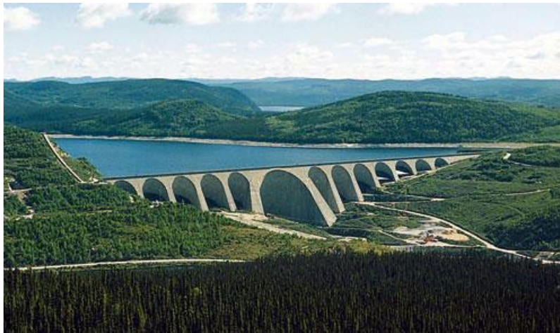
Fig. 17a. Barrage contrefort
