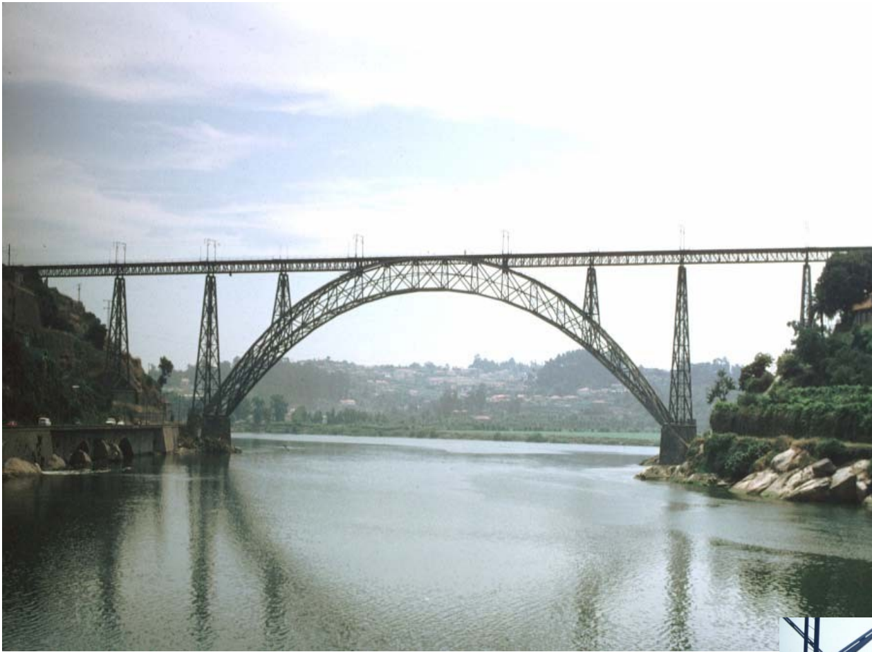
Pont Maria Pia sur le Douro à Porto, 1877
